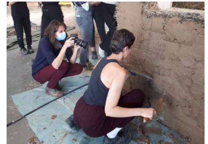
Photographie de la pose de l'enduit terre sur le mur isolé en paille
