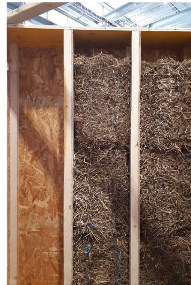
Photographie du remplissage en isolation paille de la structure bois
