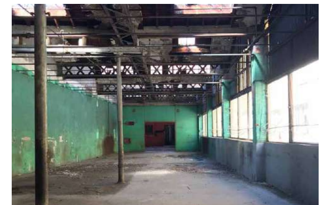
Photographie de l'intérieur - Rez-de-chaussée - Espaces fortement caractérisés par leurs couleurs intérieures et extérieures
