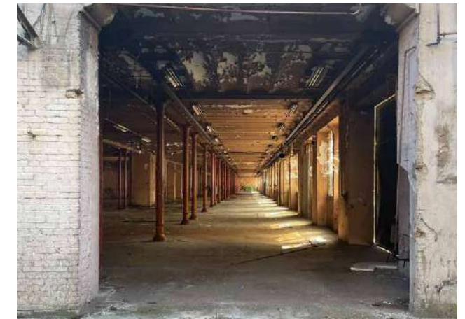
Photographie de l'intérieur - Rez-de-chaussée
