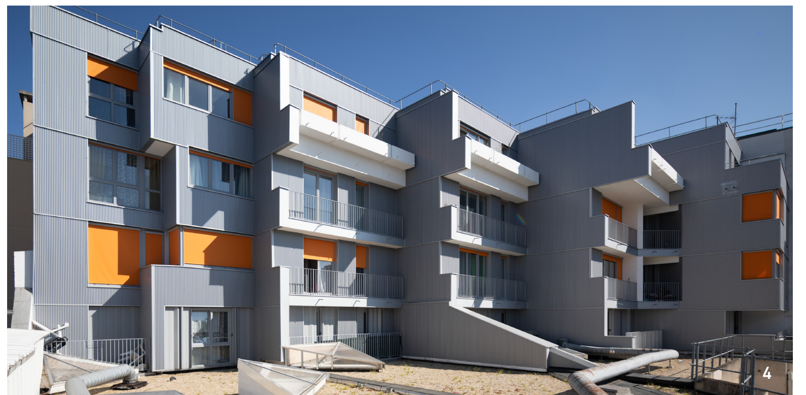
1-2 : Photos de l'état existant / 3-4 : Photos chantier
