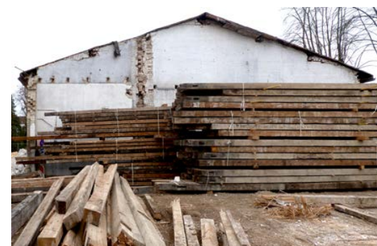
CHANTIER DE DÉCONSTRUCTION DE L'ANCIEN HÔPITAL LYAUTEY RÜCKBAUSTELLE DES EHEMALIGEN HÔPITAL LYAUTEY
