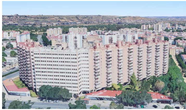
ÉTAT ACTUEL DE L'IMMEUBLE AKTUELLEN ZUSTAND DES GEBÄUDES
