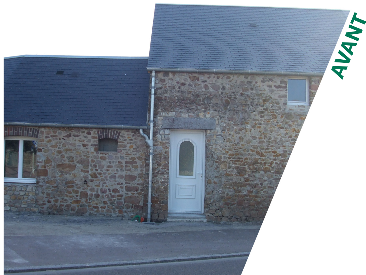
FAÇADE EXISTANTE DE L'HABITAT FAMILIAL, TRADITIONNEL DE L'ARCHITECTURE DU COTENTIN (MANCHE, FR)
