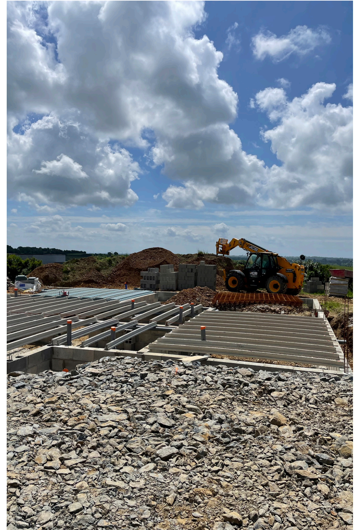
EXPÉRIMENTATION DE LA MAÇONNERIE SUR LE CHANTIER EN NORMANDIE
