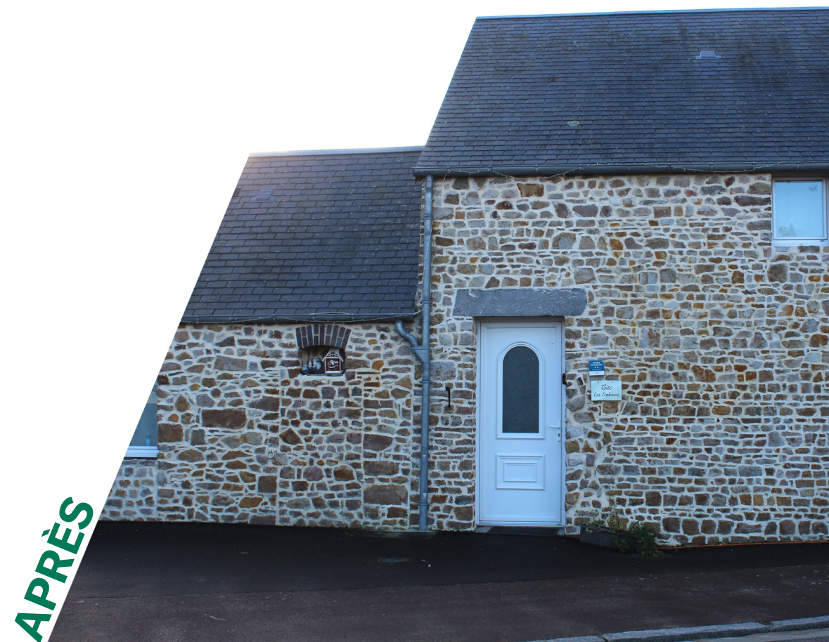
PICTAGE ET REJOINTEMENT DE LA FAÇADE
