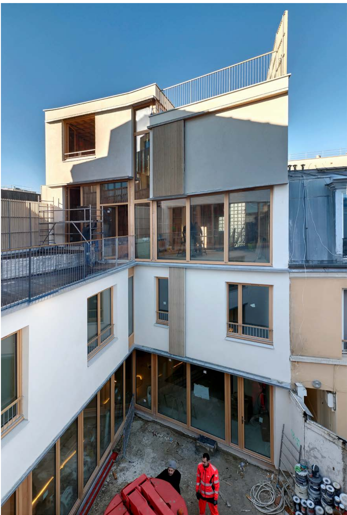
PHOTO DE CHANTIER - Vue cour ouest
