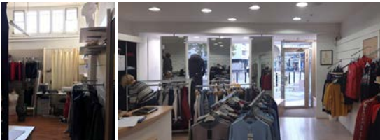
EXISTANT / Mise à nu de l'espace
