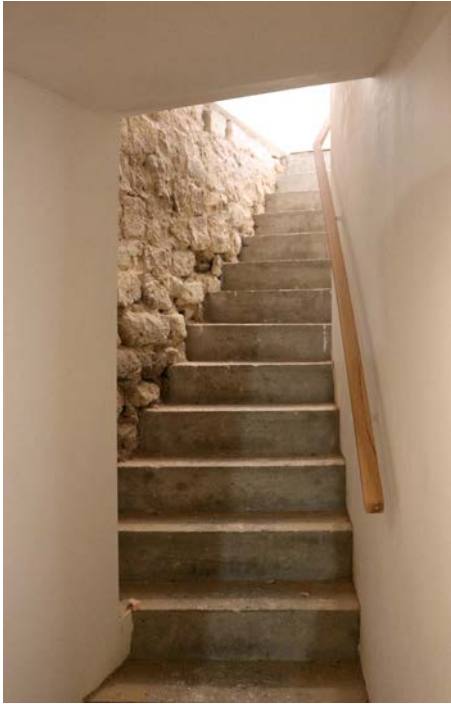
ESCALIER CAVE - Escalier béton ancrée dans le soutènement mitoyen en pierre.
