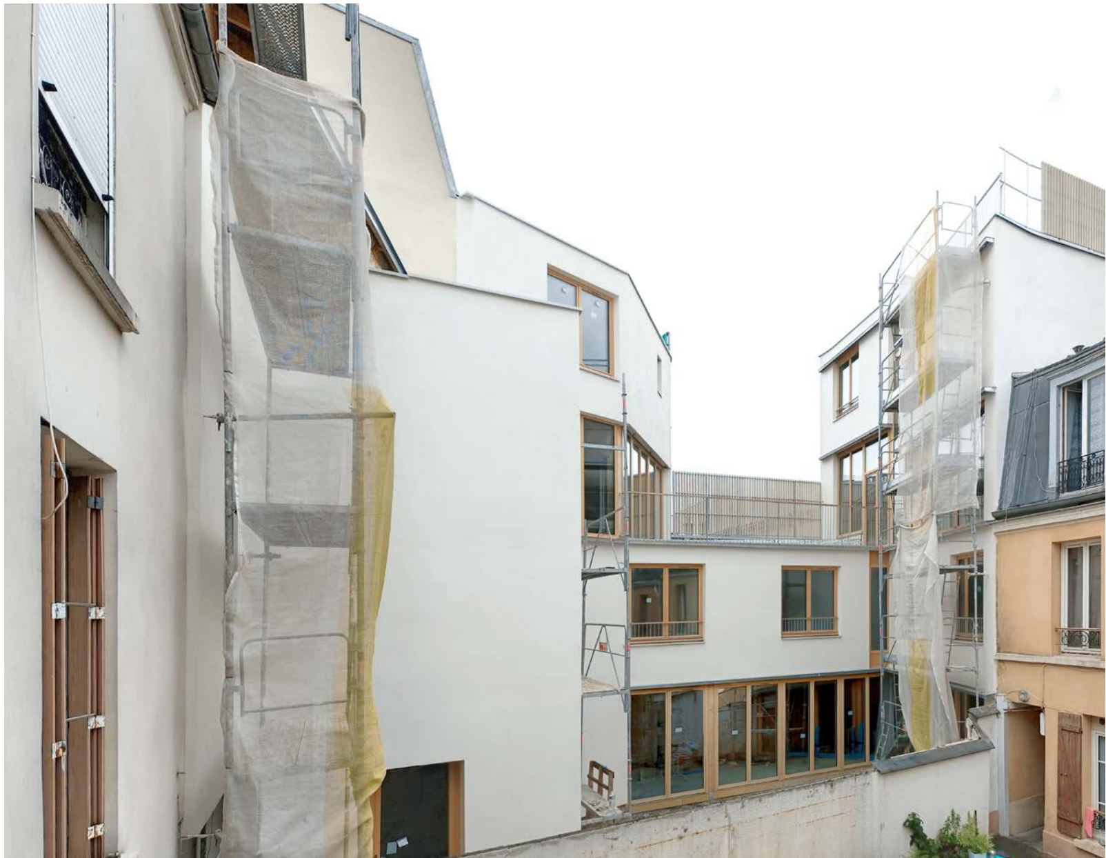
PHOTO DE CHANTIER - Vue nord-ouest
