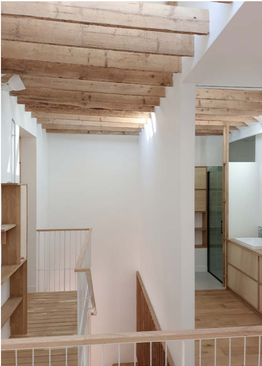
PALIER DU R+1 - Structure du plancher du grenier découverte faisant filtre zénithal.
