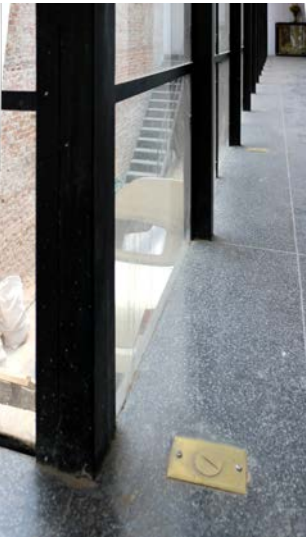
DÉTAIL - Intégration des suspentes à la dalle.
