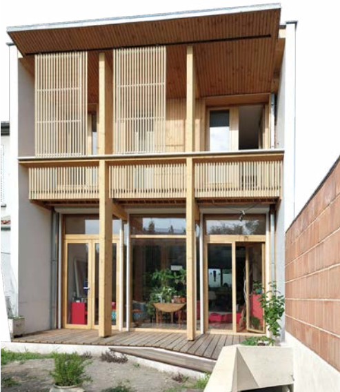
FAÇADE JARDIN - En cours de construction
