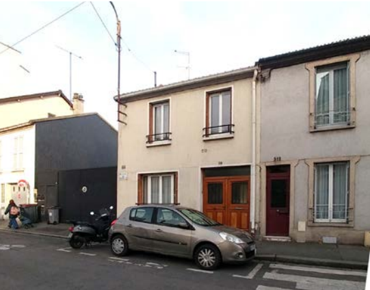
FAÇADE RUE BARBÈS, EXISTANT - Maison ouvrière
