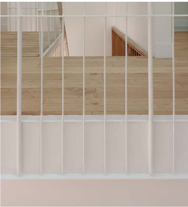
DÉTAIL - Garde corps, ronds de 6mm tendu entre lisses.
