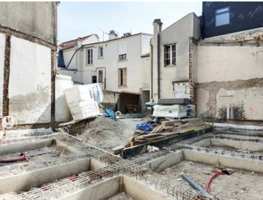
CHANTIER - Fondations mai 2023
