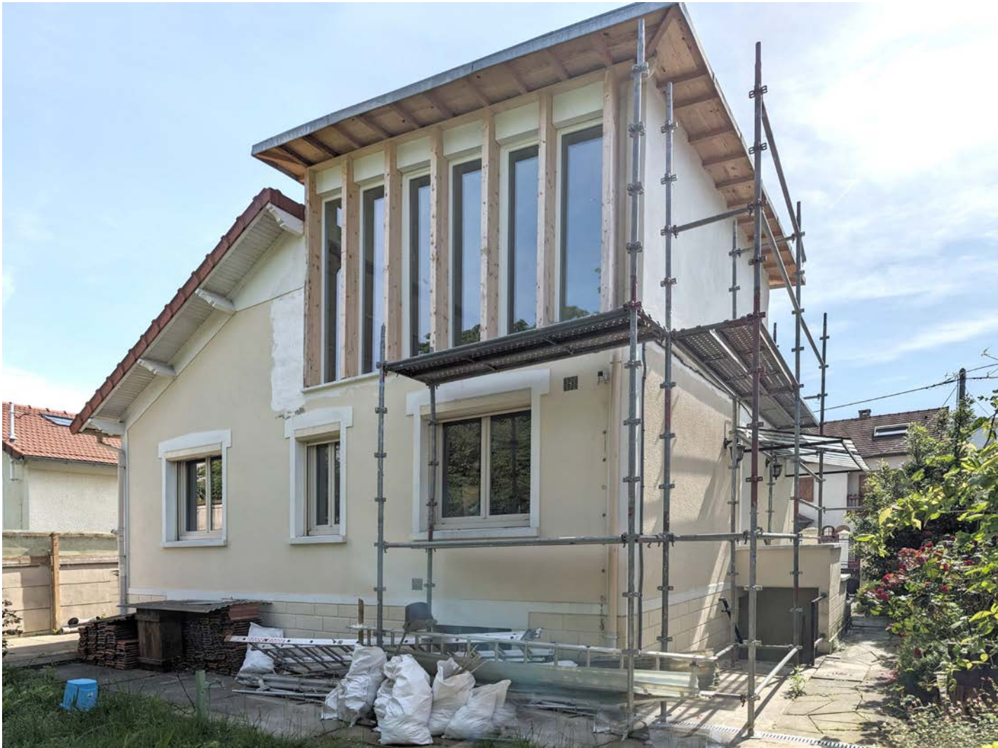
PHOTO DE CHANTIER - Vue Ouest
