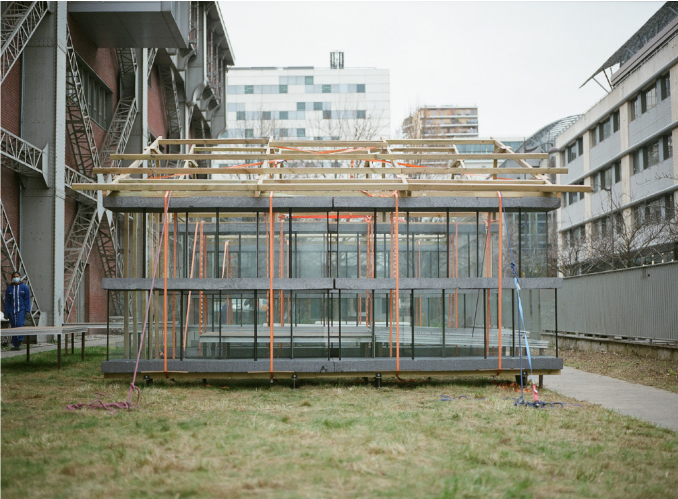
Pavillon II en construction ENSA Paris-Val de Seine - 2022
