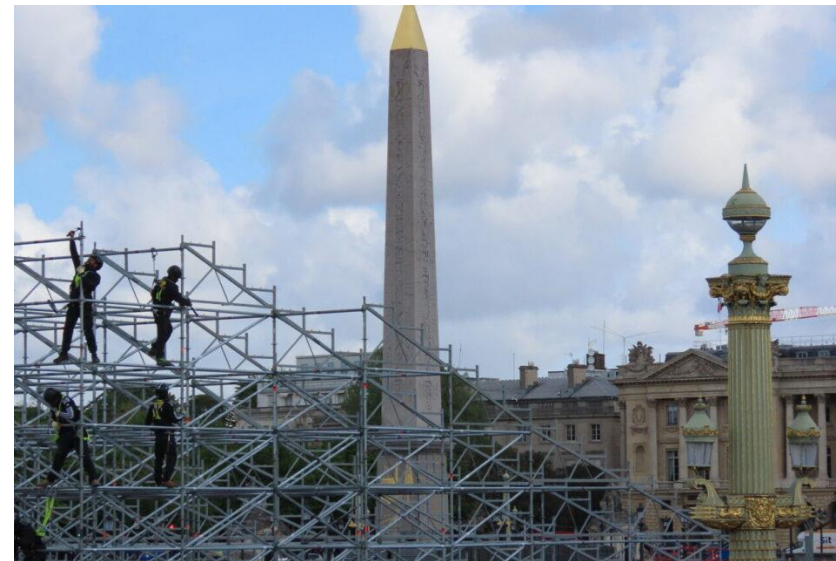
Démontage des structures des JOP24
