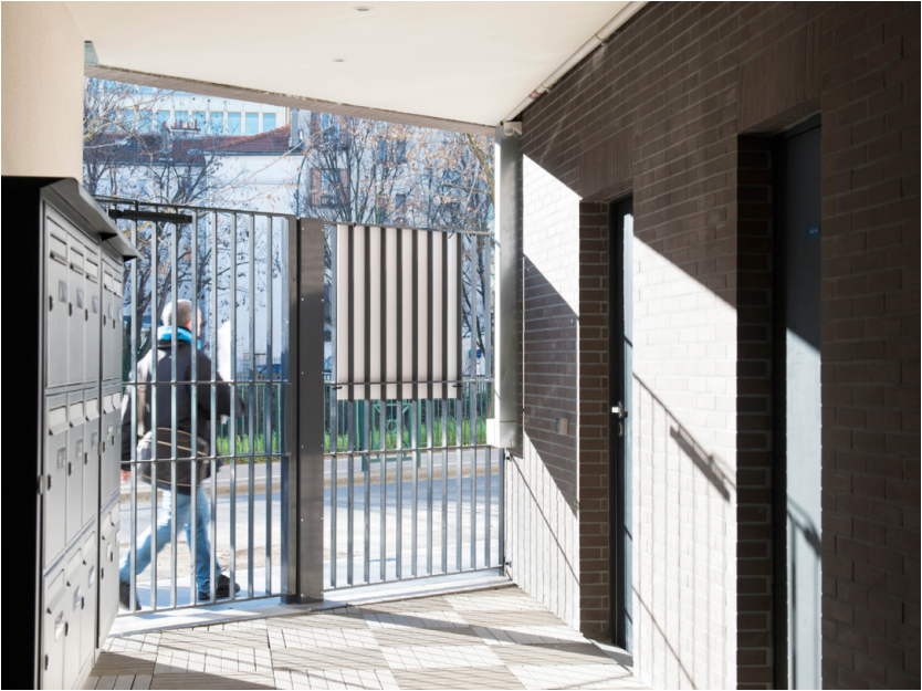
Construction de 12 logements Vincennes (94) Porche d'entrée, entre ville et cour
