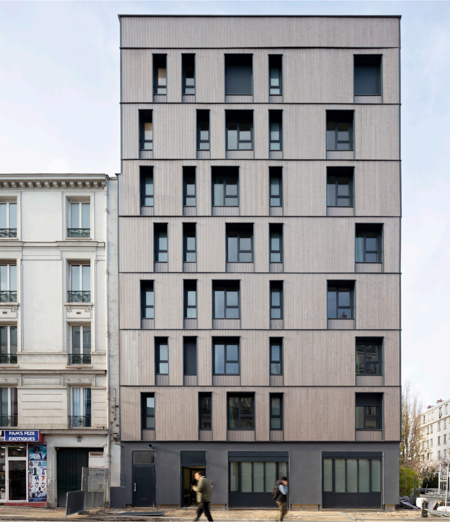
Construction de 28 logements en pension de famille, Rue de la Chapelle, Paris (18 ème ) Murs refends béton + Façades Ossature Bois (FOB) + Remplissage en textile recyclé (© métisse) + Bardage bois pré-grisé
