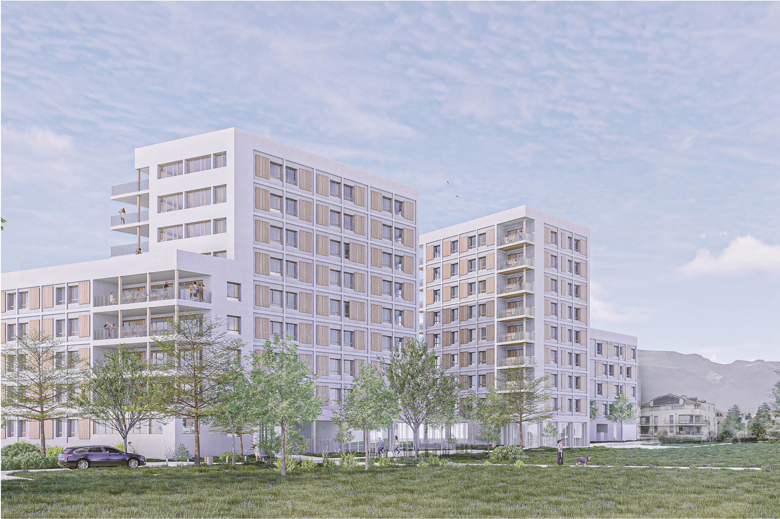
Construction de 130 logements mixtes en coliving, Ferney-Voltaire (01) Construction Hors-site : Murs Ossature Bois (MOB) + Façades Ossature Bois (FOB) + Remplissage béton de chanvre
