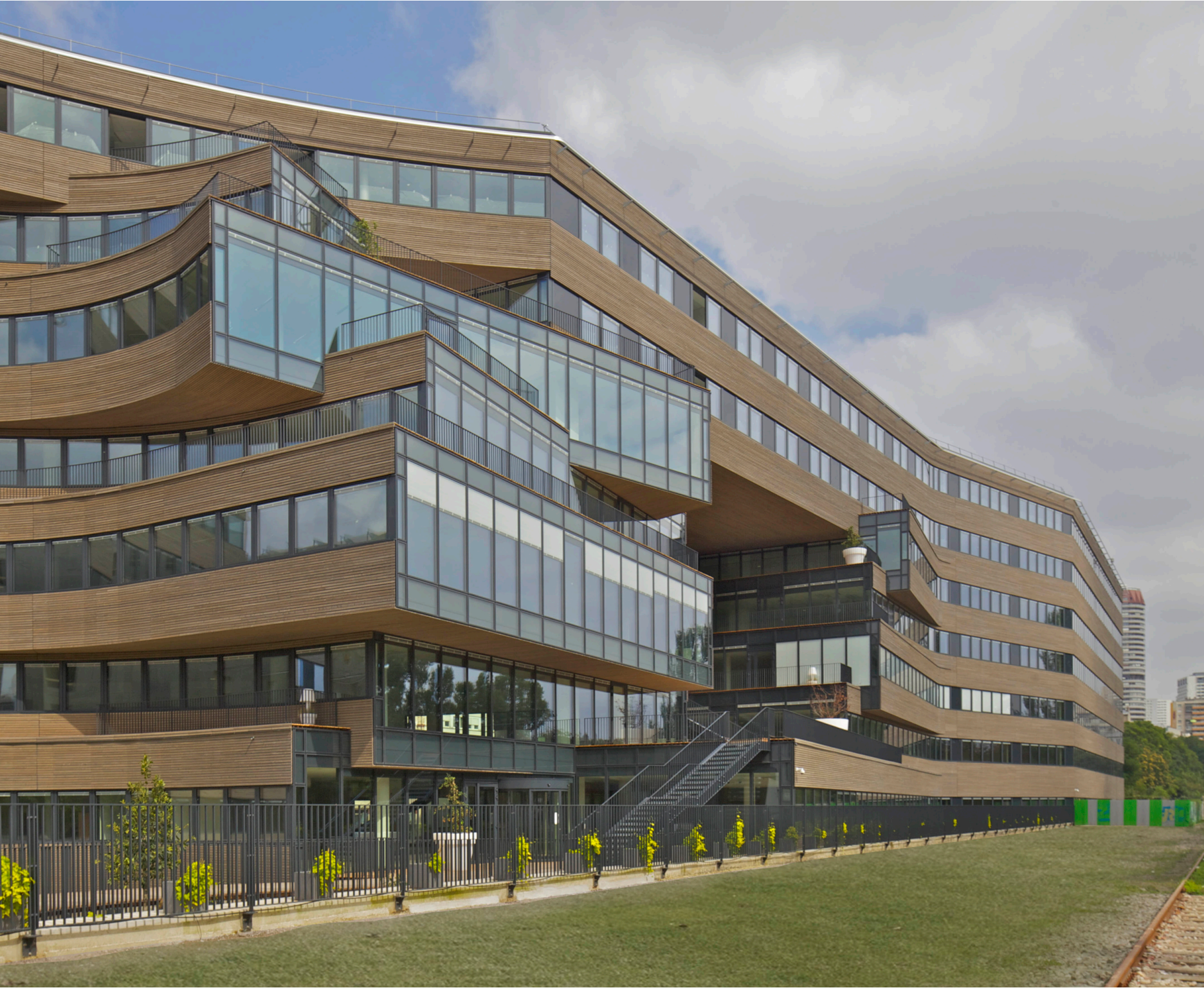
Construction d'un Immeuble de 20 000 bureaux avec MVRDV, ZAC gare de Rungis, Paris (13 ème ) Le paysage urbain est composé d'objets qui doivent participer à la narration de la ville. Leur échelle est une de ces histoires
