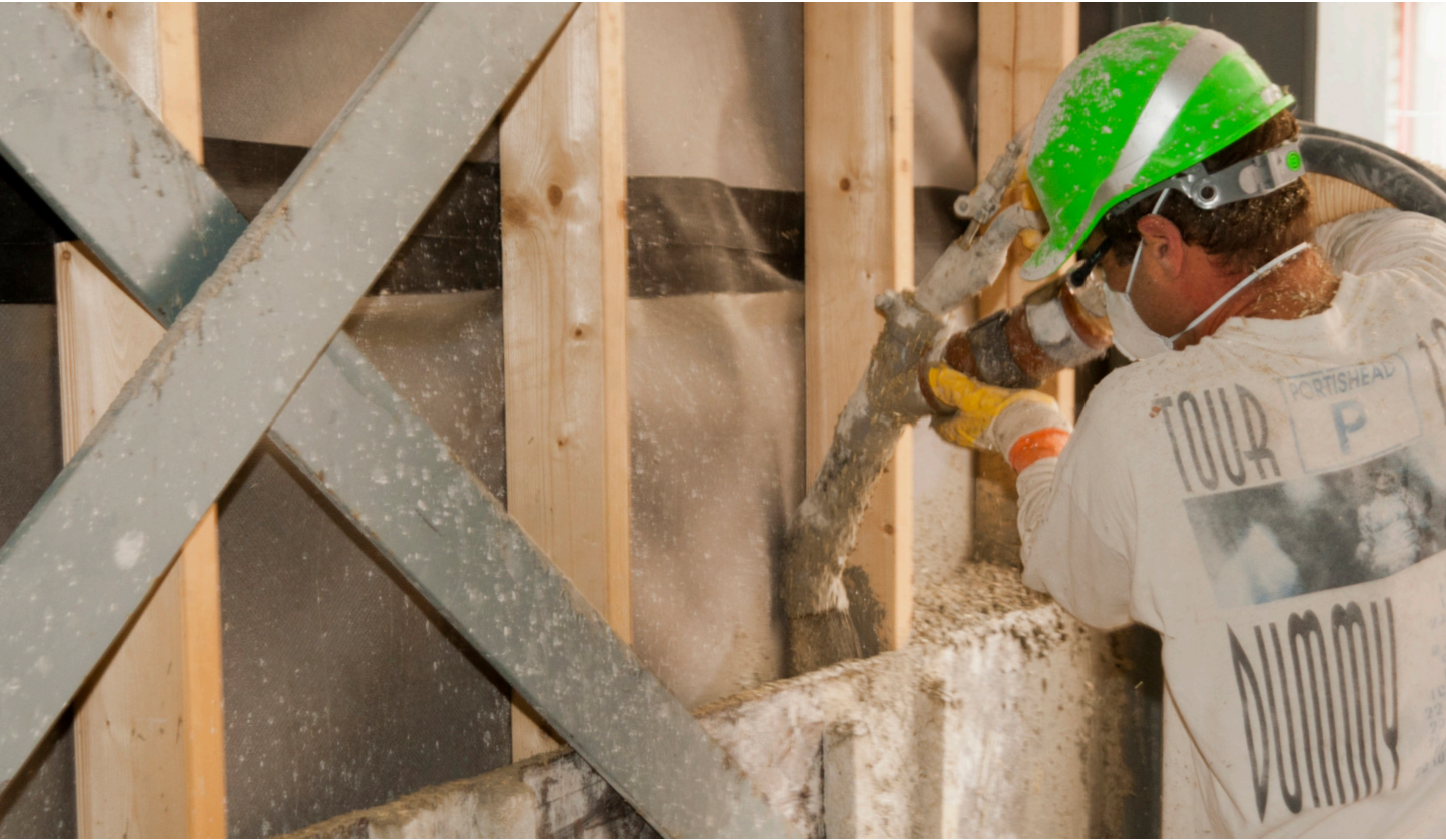
La légèreté du béton de chanvre apporte une réponse qualitative aux questions posées par un sous-sol fragile, un contexte urbain dense et une parcelle exiguë
