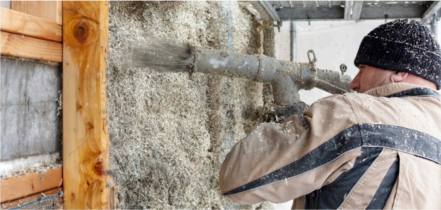
L'immeuble de Boulogne-Billancourt est le premier bâtiment d'Europe à R+8 en béton de chanvre La faible épaisseur des parois permet de gagner 16m² de SHAB par rapport à un mode constructif traditionnel
