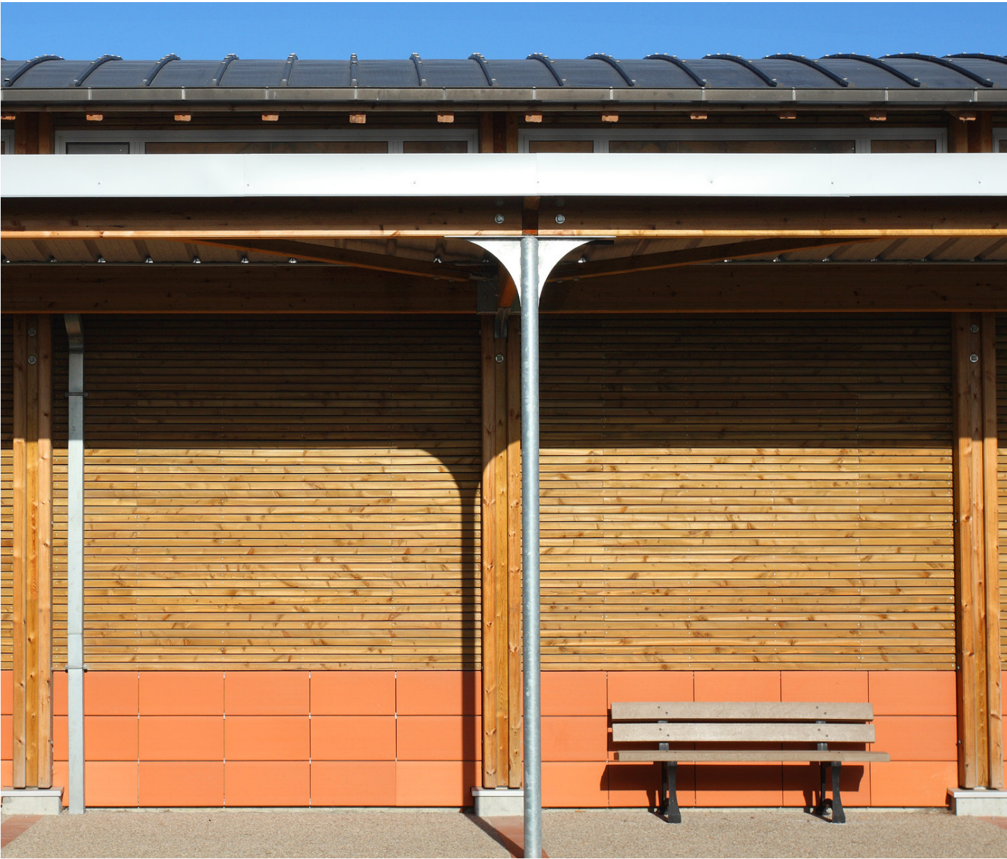
Réhabilitation de l'ancienne gare en médiathèque, Périers (50) Ossature bois + Bardage terre cuite/ bois
