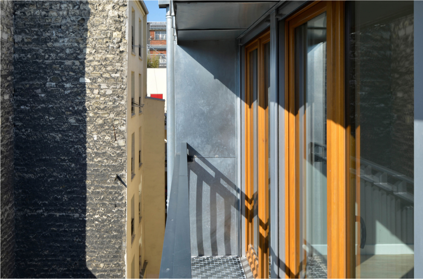
Construction de 4 logements, Paris (18 ème ) Loggia, ouvrir pour être dehors/dedans
