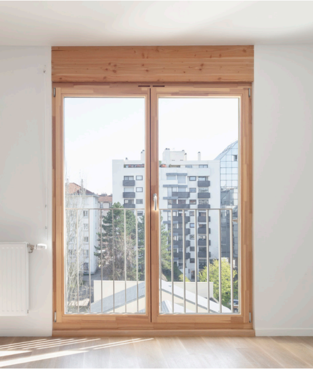
Construction de 15 logements, Boulogne-Billancourt (92) Lumière naturelle et vues cadrées au service du confort de l'habitant
