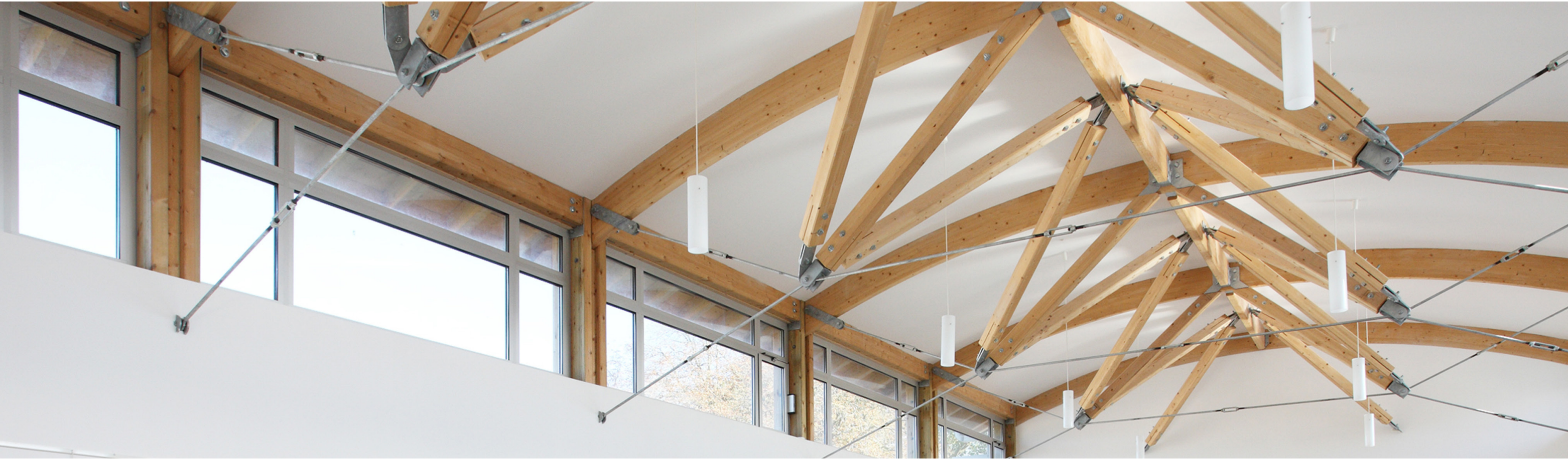
Réhabilitation de l'ancienne gare et transformation en médiathèque et office de cyclotourisme à Périers (50) Vue intérieure, la charpente a été dessinée pour qualifier l'espace et participer pleinement à sa lisibilité spatiale
