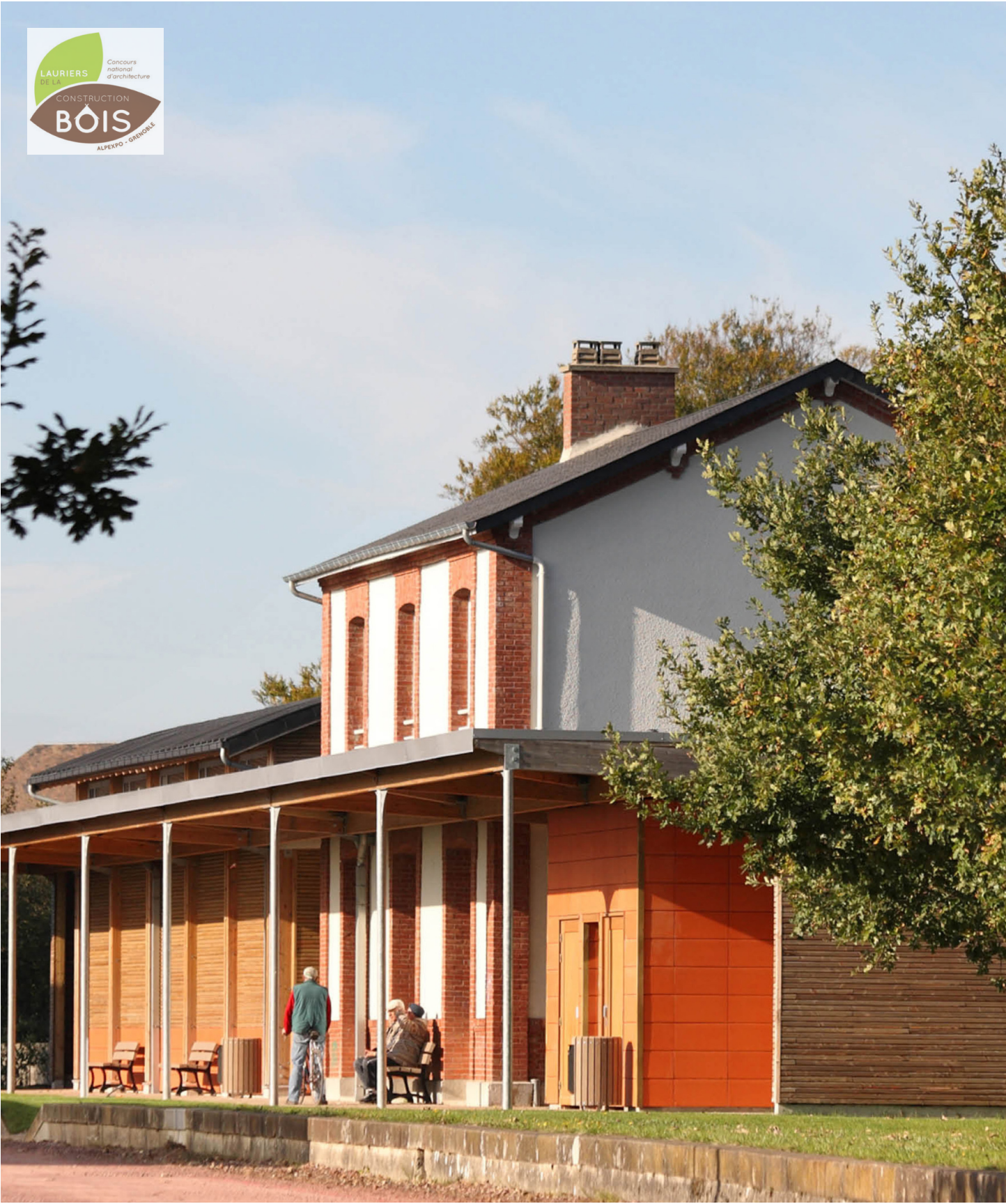
La gare comme espace de passage entre voie ferrée et ville Préserver dans le projet les qualités d'usages originelles
