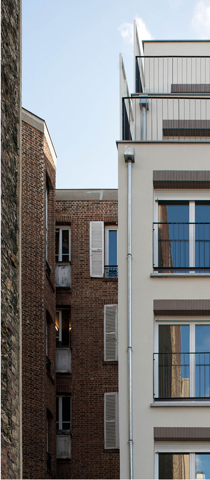
Construction de 12 logements, Avenue Aubert, Vincennes (94) Densifier la ville en préservant l'habitabilité des riverains
