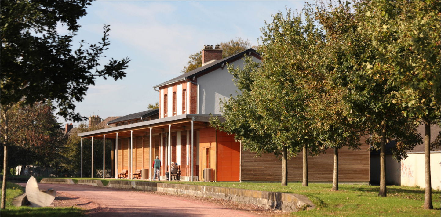
Réhabilitation de l'ancienne gare et transformation en médiathèque et office de cyclotourisme à Périers (50) Projet lauréat « Lauriers de la construction bois, 2012 » et Mention spéciale du Jury « Palmarès Régional du CAUE »
