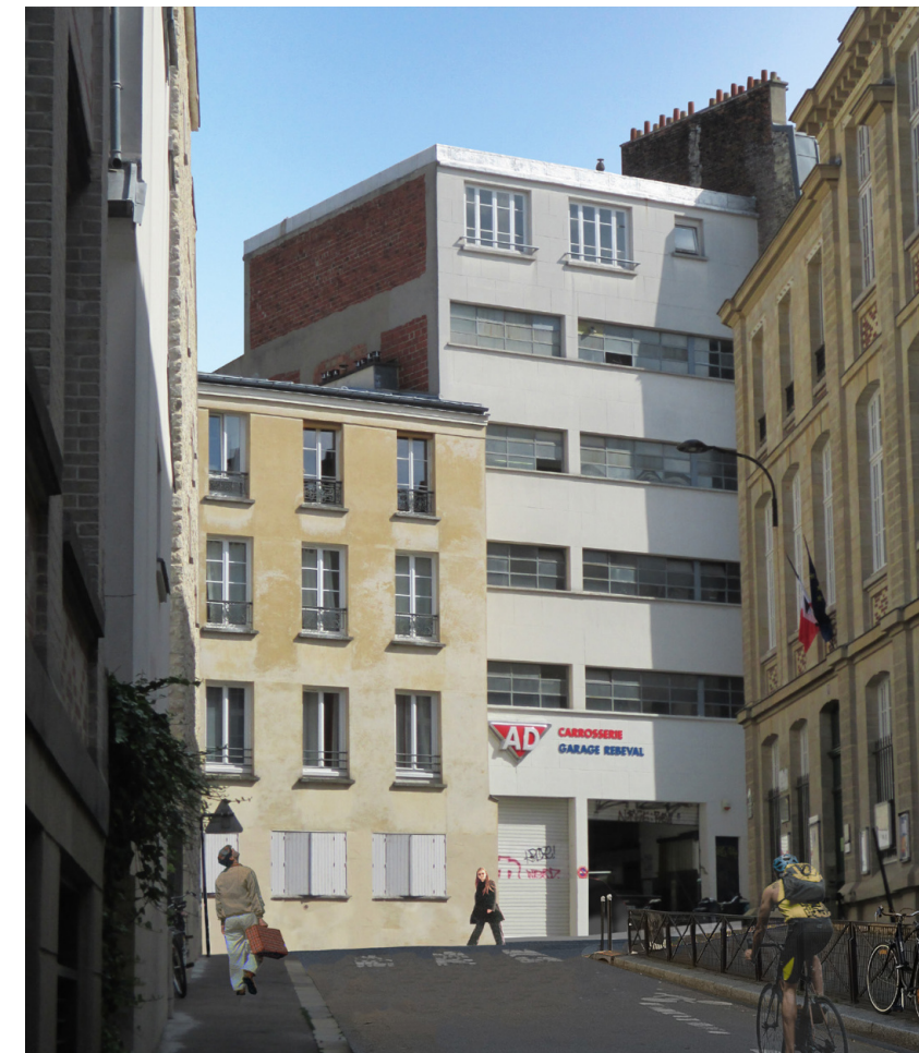
Transformation et surélévation d'un garage en 6 logements & 1 local d'activité 77 rue Rébéval, Paris (19 ème ) - NF Habitat HQE, Paln Climat Paris, BEE
