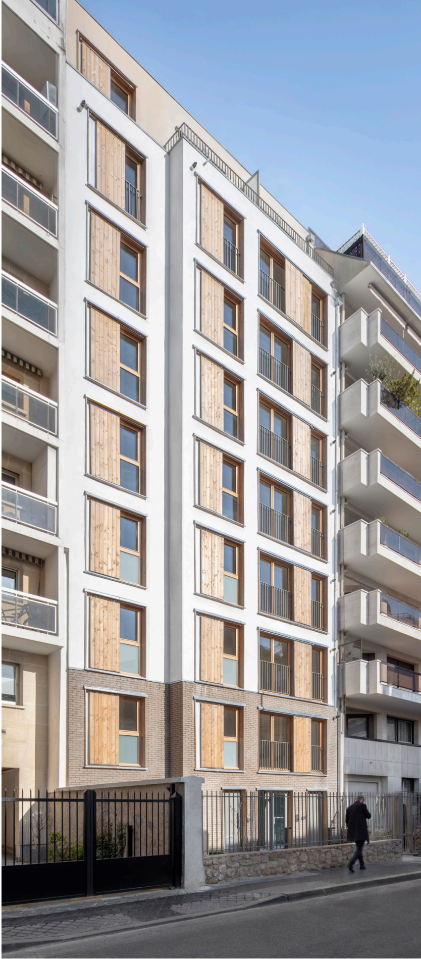
Construction de 15 logements, Rue de Bellevue, Boulogne-Billancourt (92) Murs refends béton + façades bois + remplissage en béton de chanvre
