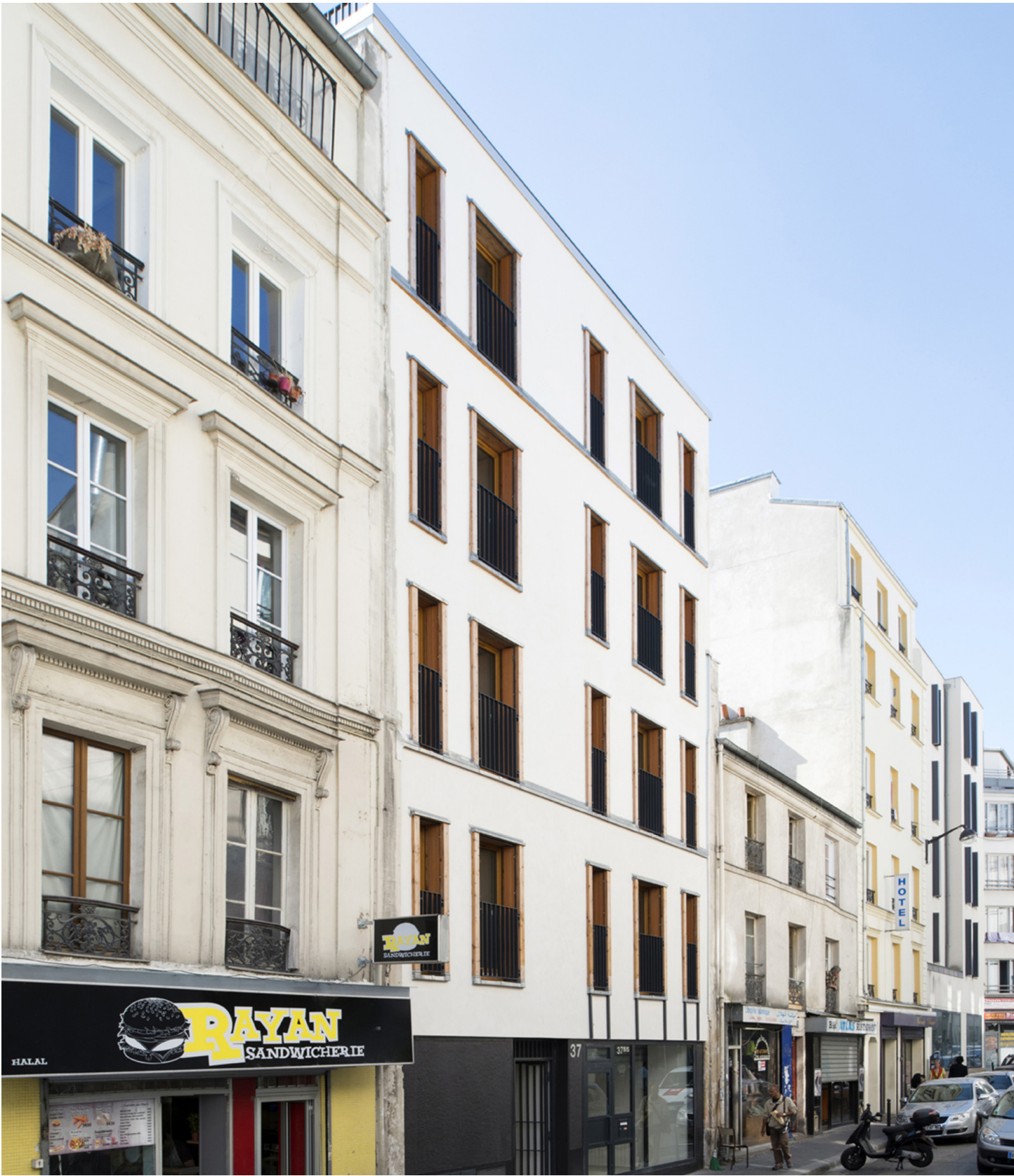
Construction de 4 logements, Rue Myrha, Paris (18 ème ) Ossature mixte bois/métal + remplissage en béton de chanvre projeté
