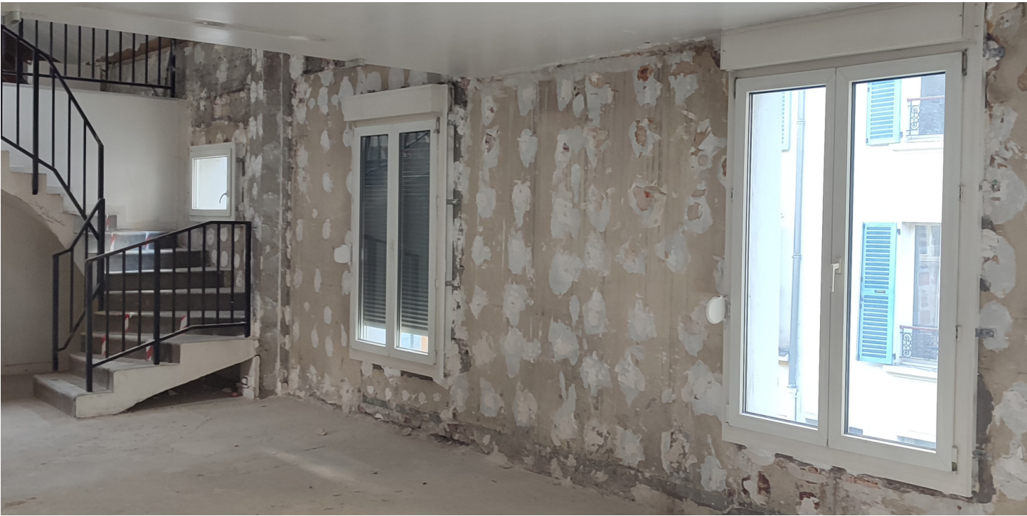
Chantier en cours, livraison prévue Mai 2025 Double emploi du chanvre pour sa légèreté en surélévation et ses performances thermiques en isolation sur bâtiment existant (voir axes ci-dessus)
