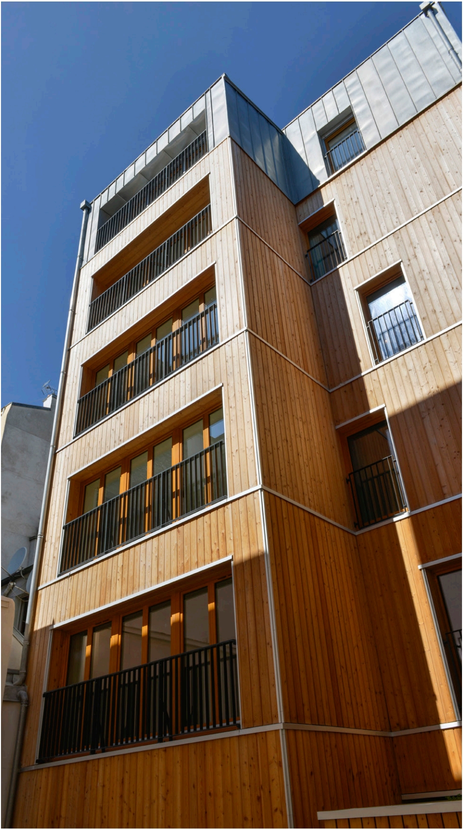
Construction de 4 logements, Rue Myrha, Paris (18 ème ) Ossature mixte bois/métal + Bardage bois
