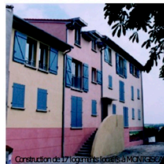
Construction de 17 logements locatifs à MONTGISCARD
