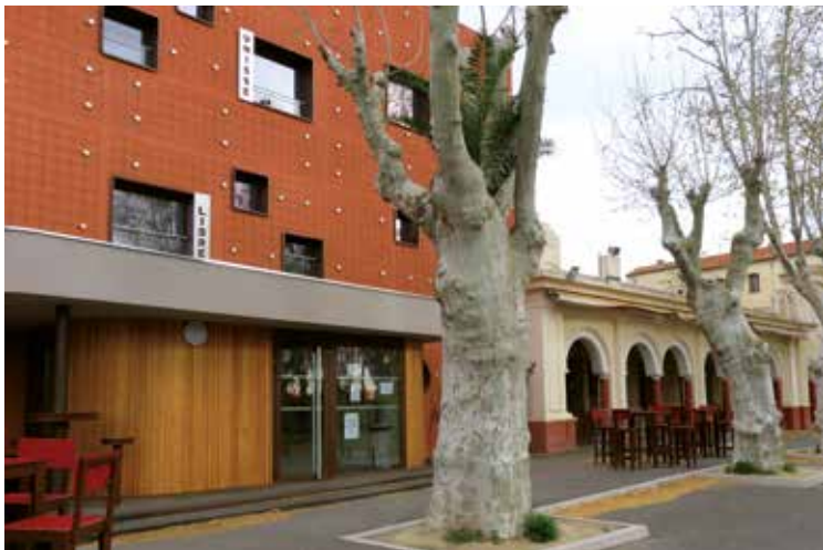
Extension de l'Institut Saint-Louis de Gonzague, Perpignan (66), 2014, Edificat/Rosello & Sanganis arch. © Nicolas Bonafé - Edificat
